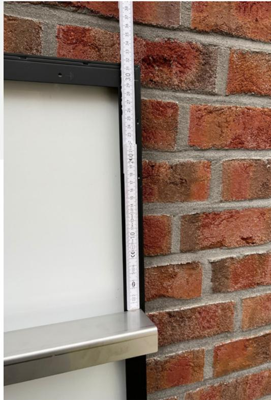
Die Wandprofile links und rechts 10cm eingerückt zur Gesamtlänge der Wandhalter am Modul. In diesem Beispiel ist das Abstandsmaß 855mm.
